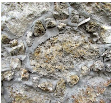
Mur en meulière, avec joints de rocaille
