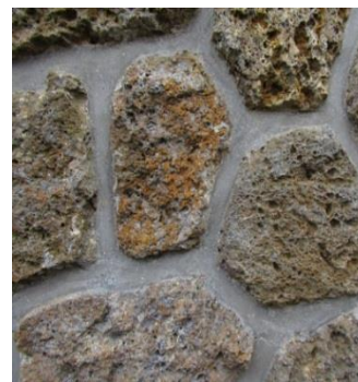
Meulière de la Ferté sous Jouarre, joint creux
