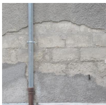
Maison en parpaing de graveluche Avec enduit
